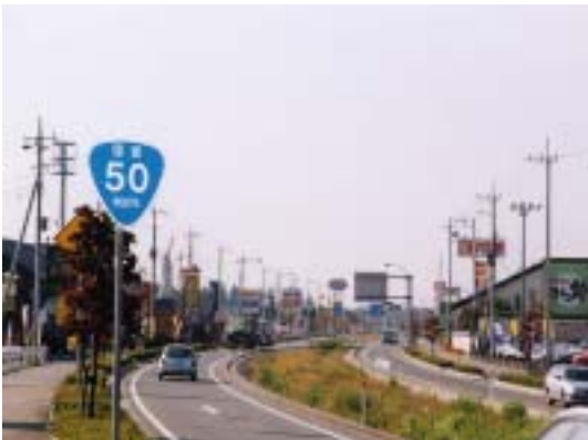
写真2 国道50号線バイパス
